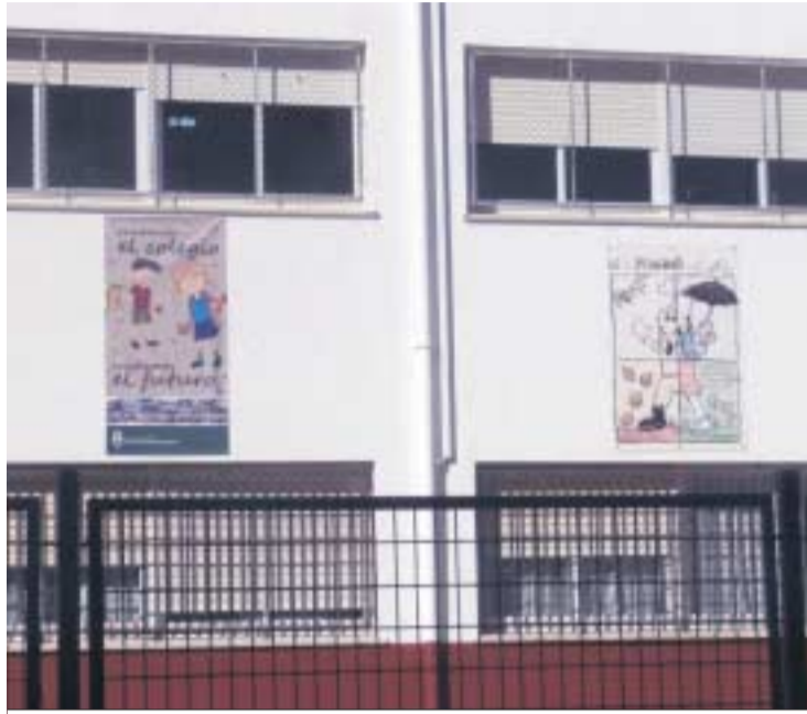
Uno de los carteles recientemente instalados en el colegio Las Nieves.
